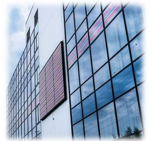
Imagen de la instalación en fachada del módulo HeliaFilm.
