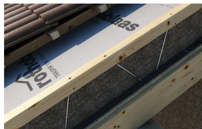
Viti DGZ per il collegamento continuo dello strato isolante
